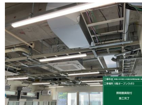
桐生キャンパス 研究室 LED照明へ更新
