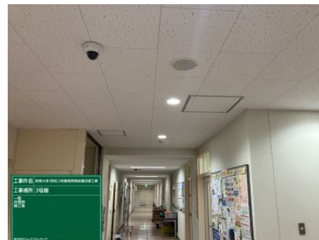
荒牧キャンパス 廊下 LED照明へ更新
