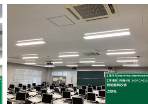
桐生地区 CAD室 LED照明への更新後
