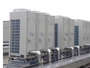
昭和地区 附属病院 診療棟の空調機更新後
