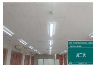
若宮地区 附属学校校舎 学習室 LED照明への更新後
