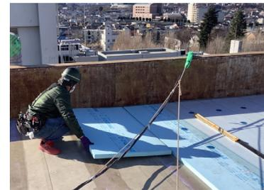
屋根上外断熱材の敷き込み
