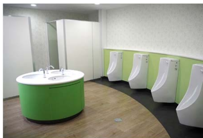
附属小学校トイレ改修 (R2)
