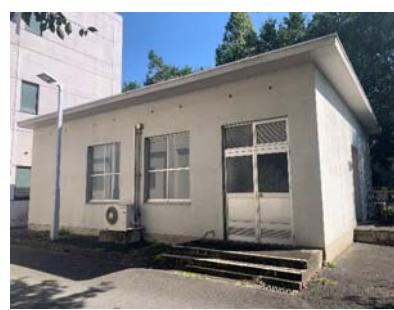
低層の施設（R I 実験施設）
