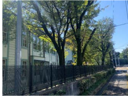
道路沿いの敷地境界フェンス
