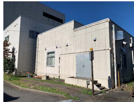
低層の病院施設
