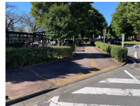
点字ブロックと車両動線の交差
