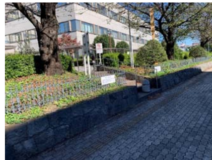
敷地境界フェンス②
