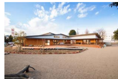
附属幼稚園舎改築 (H29~30)
