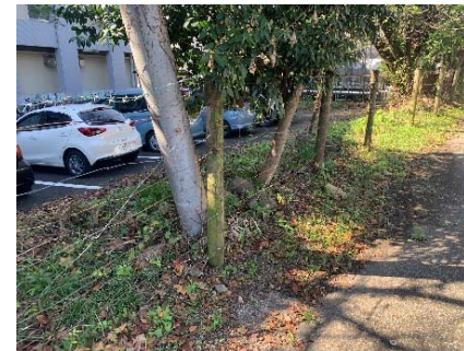
敷地境界フェンス(簡易針金)
