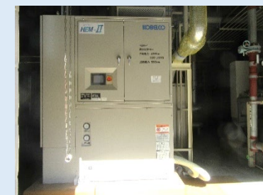
水冷チラーを高効率の熱回収チラー（冷水・温水同時取出し）に更新
