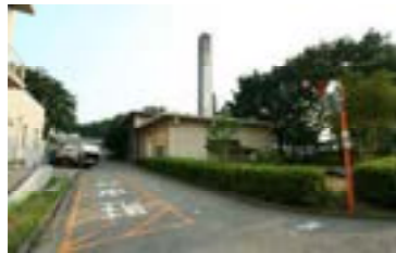
取り壊し予定建物
