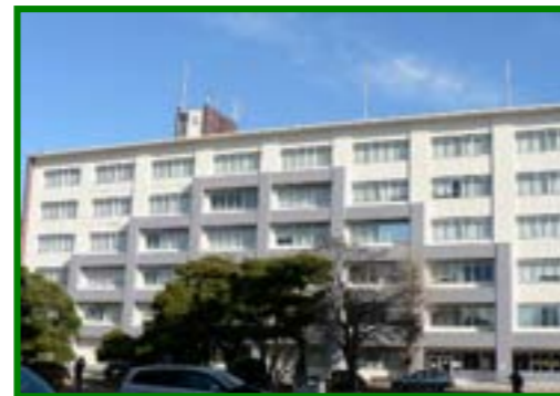
16 (工)4号館改修(16補正 耐震・老朽)
