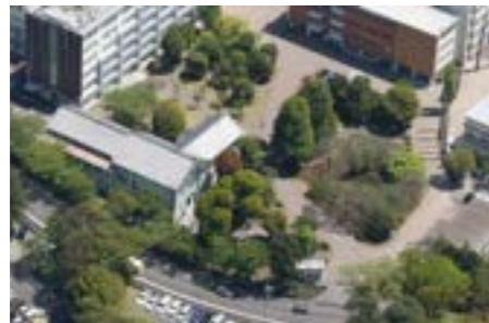
保存地区・保存建物
