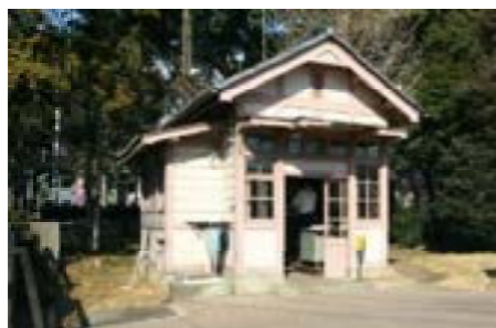
保存建物 (守衛所)
