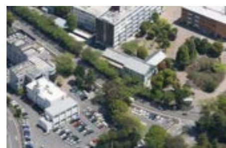
西側県道出入口付近
