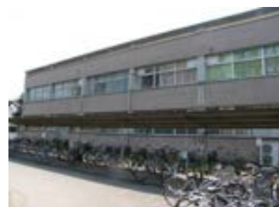
GB棟駐輪場再整備
