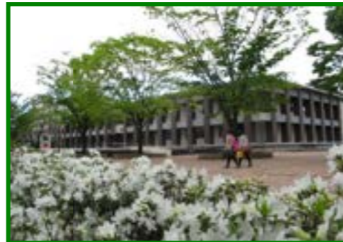
3 (荒牧)図書館改修 (19補正 耐震・老朽)
