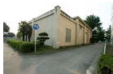
旧特高受電室
