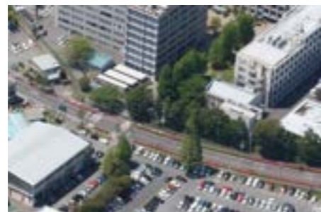
東側市道出入口付近
