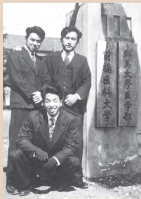
昭和25年、医学部正門前で。当時は「前橋医科大学」と「群馬大学医学部」の2枚の看板が並べて掲げられていました。なお、当時の正門前の道路は未舗装でした
