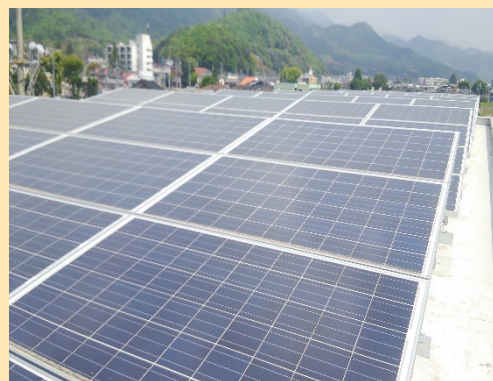
課外活動施設屋上
