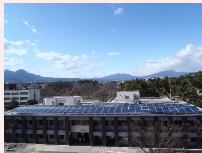
中央図書館屋上
