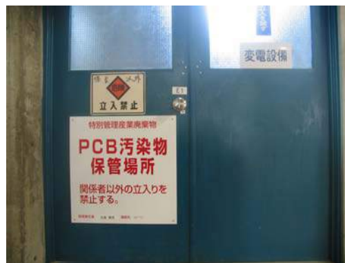
荒牧団地PCB保管場所（2014.7撮影）
