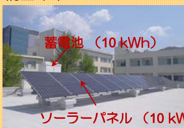
工学部会館屋上
