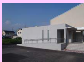
非常用トイレの設置
