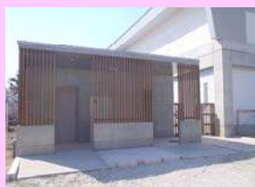
非常用トイレの設置
