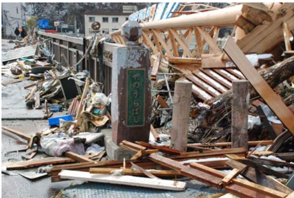
写真3. 釜石市内海岸付近の橋 (2011.3撮影)
