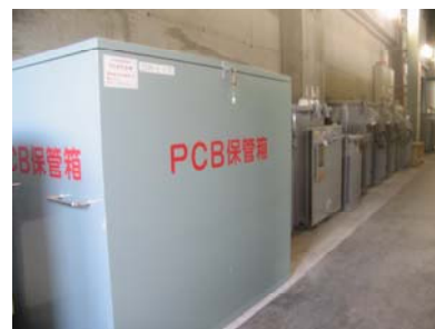
荒牧団地PCB保管状況 (2014.7撮影)
