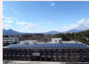
中央図書館屋上
