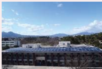
中央図書館屋上
