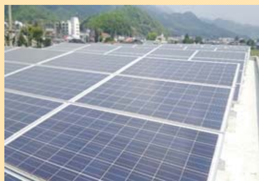
課外活動施設屋上
