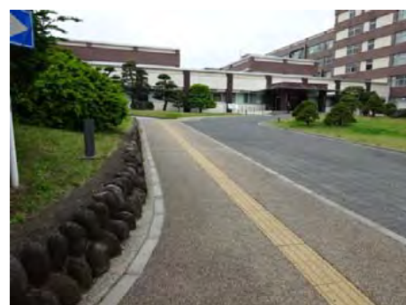
教育学部付近点字誘導ブロック
