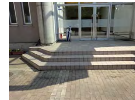
小学校体育館玄関段差
