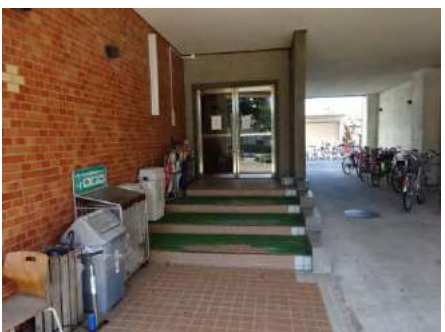
保健学科西棟玄関段差
