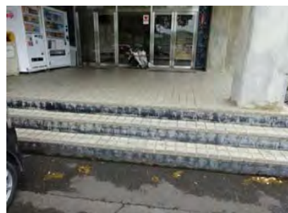
体育館玄関段差
