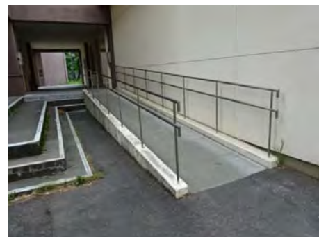
教育学部E棟スロープ
