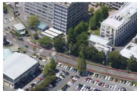
東側市道出入口付近
