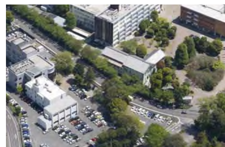
西側県道出入口付近
