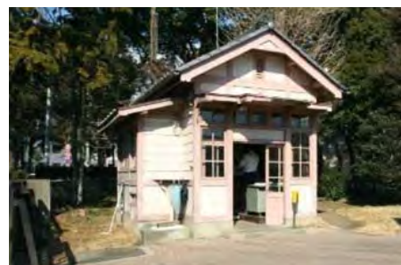
保存建物(守衛所)
