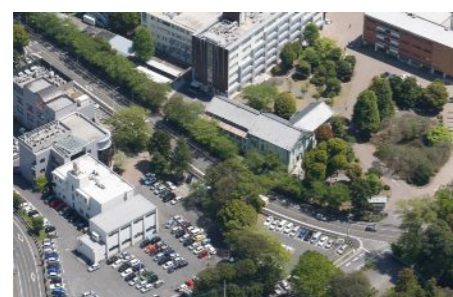
西側県道出入口付近
