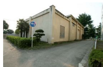
旧特高受電室
