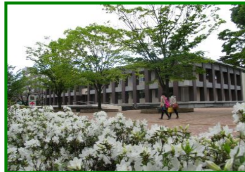
3 (荒牧)図書館改修 (19補正 耐震・老朽)
