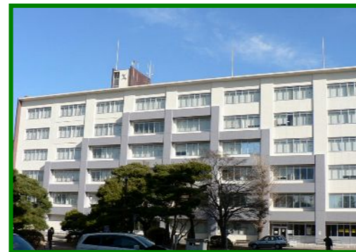
16 (工)4号館改修(16補正 耐震・老朽)
