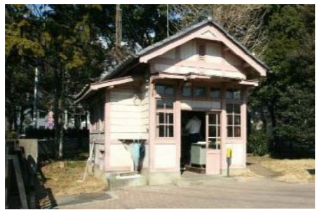
保存建物 (守衛所)
