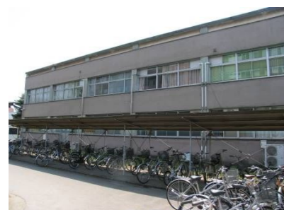
GB棟駐輪場再整備
