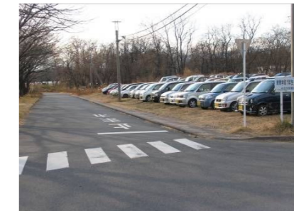
北側仮駐車場から主動線への割り込みを禁止するための車止めを設置。
