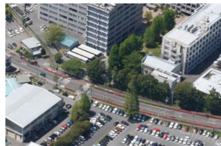
東側市道出入口付近
